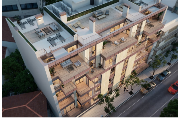
fassade von oben penthaua
